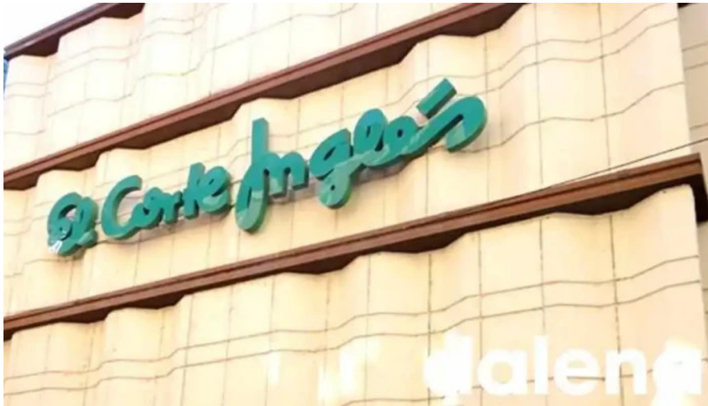
El corte ingles la moneda edificio 1 burgos
