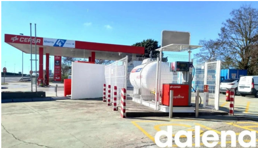
Estacion de servicio mueve antes cepsa surtidor de combustible
