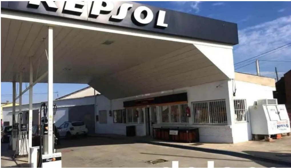
Estacion de servicio repsol exterior
