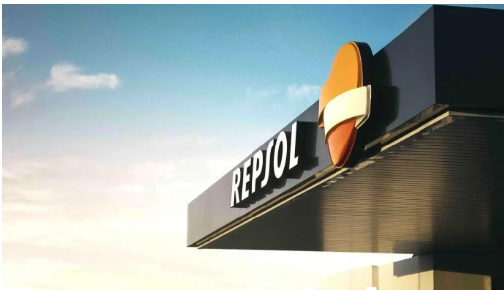
Estacion de servicio repsol del propietario
