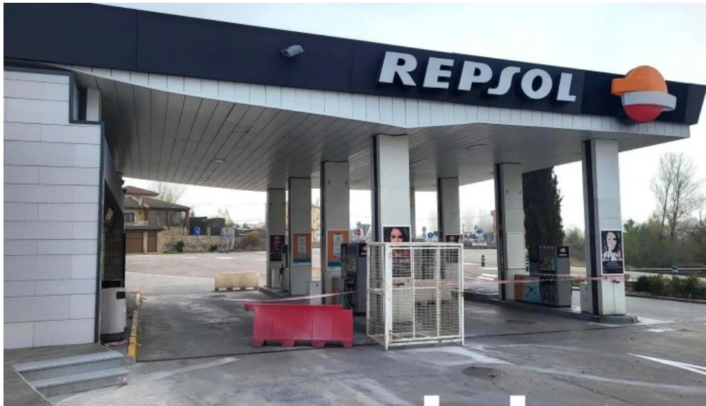
Estacion de servicio repsol exterior
