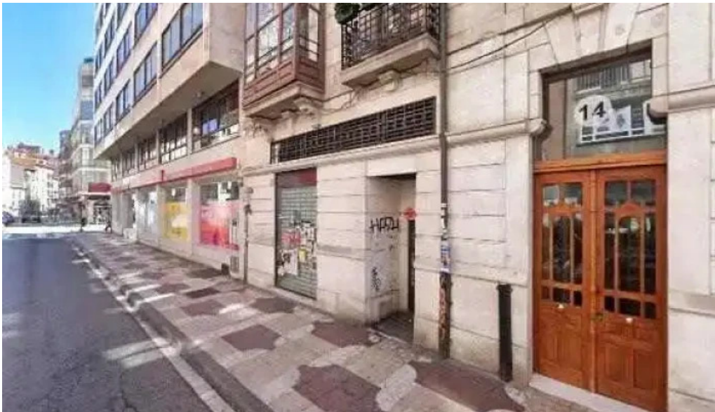
Primaprix burgos calle miranda ubicacion
