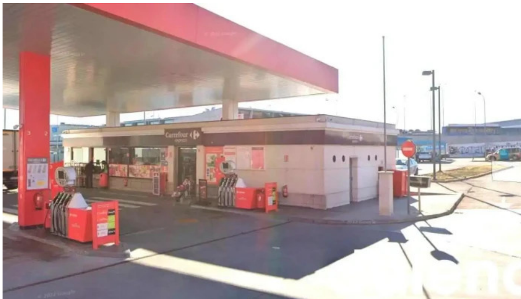
Carrefour express eess estacionamiento
