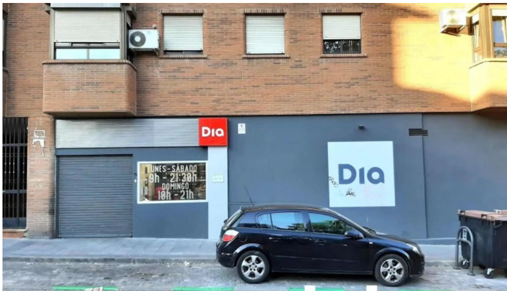
Supermercados dia estacionamiento
